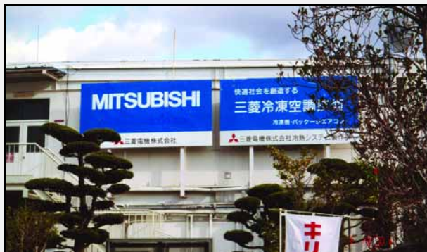
Завод Wakayama по производству мультizonальных систем СИТИ МУЛЬТИ и холодильного оборудования.
