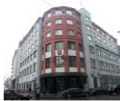
Одним из примеров применения систем «DAIKIN» Hi-VRV в нашей стране служит проект кондиционирования здания Мосгордумы, осуществленный в 2000 году
