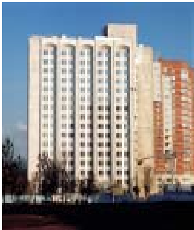
Фото 1. Офисно-деловой 16-этажный комплекс
