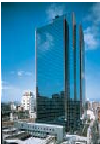
Здание Умеда-центра (Осака), в котором была установлена одна из первых систем VRV. В этом здании расположена штаб-квартира «DAIKIN Industries Ltd.»
