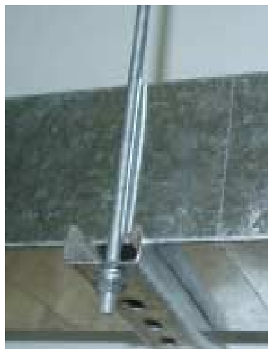
Фото 1.3. Крепление при помощи траверса и шпильки
