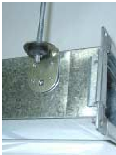
Фото 1.2. Крепление при помощи L-образного профиля и шпильки
