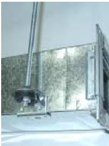
Фото 1.1. Крепление при помощи Z-образного профиля и шпильки
