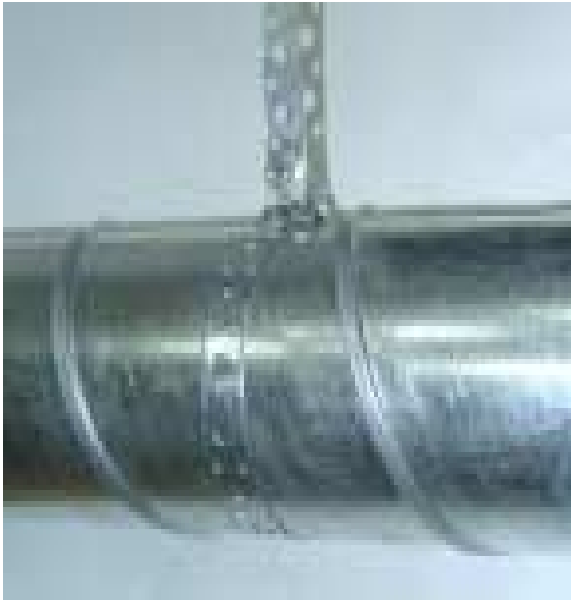
Фото 3.1. Крепление при помощи перфоленты без хомута
