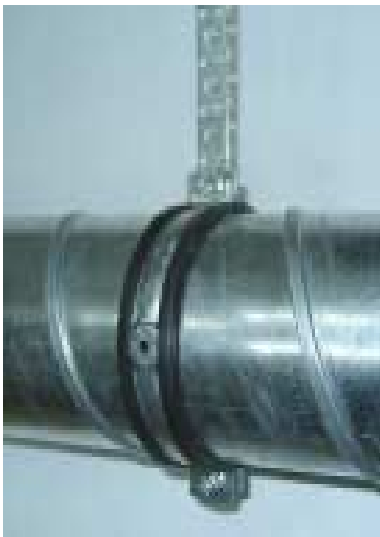
Фото 3.2. Крепление при помощи перфоленты с хомутом
