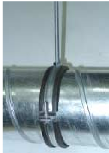
Фото 2.1. Крепление при помощи хомута и шпильки
