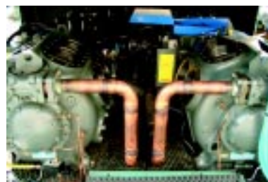
Сердце большой установки временно не бьется — результат неправильного запуска после зимы.
