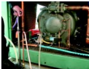
Прокачка маслом кривошипно-шатунного механизма при помощи ручного масляного насоса.
