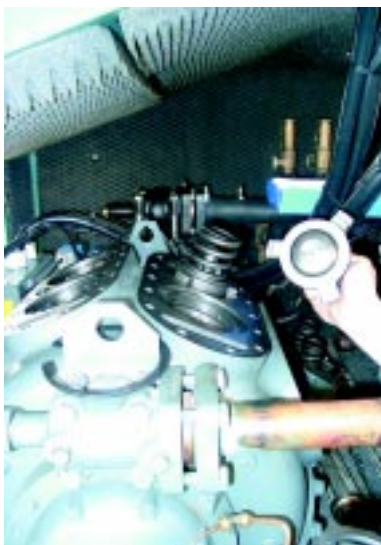
Один из фрагментов дорогостоящего ремонта — замена поврежденных клапанов.
